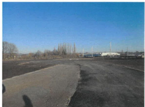
Bild 108: Blick auf den Wendehammer der Baustraße im Norden (23.11.2018)
