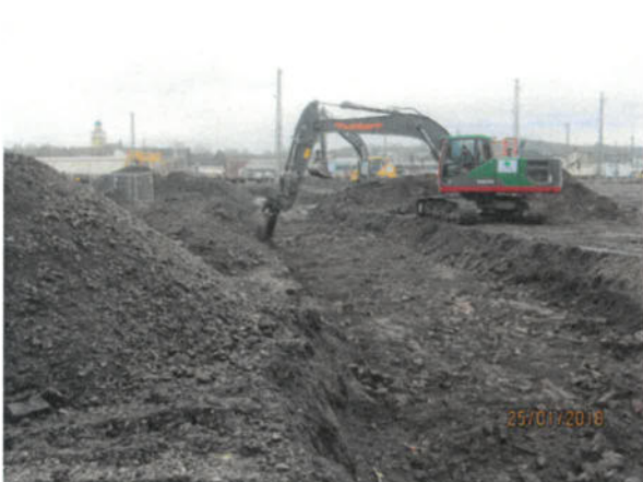
Bild 33: Verfüllungsarbeiten im Bereich des angelegten Suchschurfes südlich 1. TB (25.01.2018)
