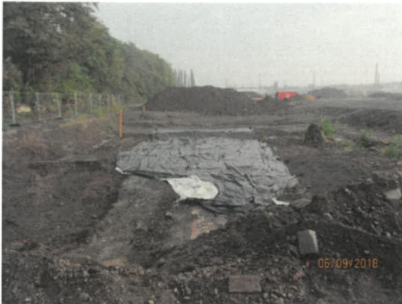
Bild 91: Abgedeckte, vermutete Kontamination im Südwesten; nach Analytik entfernt und entsorgt (06.09.2018)
