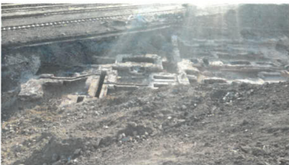
Bild 45: Blick von der zentralen Bodenmitte nach Osten (28.02.2018)
