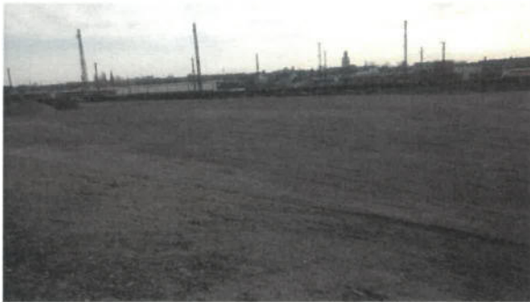
Bild 61: NRW.URBAN-Fläche mit RC-Schotter-Abdeckung (10.04.2018)
