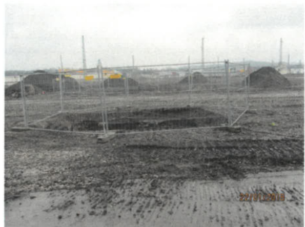
Bild 28: Vorläufige Sicherung des ersten Tagesbruchs (22.01.2018)
