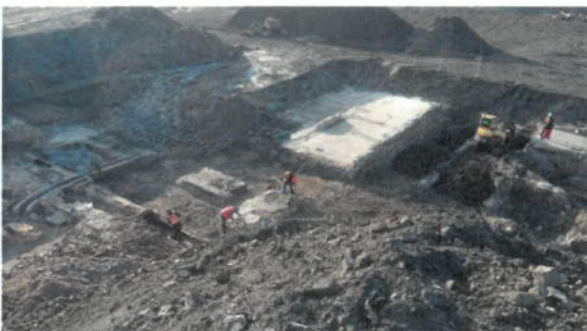
Bild 41: Freilegung von ehemaligen Leitungen, Maschinenfundamenten und Räumen der Steinhauser Hütte (28.02.2018)
