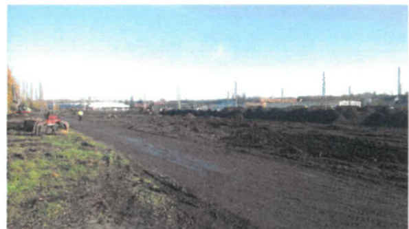
Bild 12: Blick von SW nach NE; auf der Fläche abgesiebtes und bereitgestelltes Bodenmaterial (17.11.2017)
