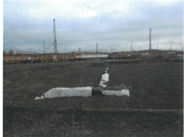
Bild 104: Mit Vlies und Boden abgedeckter "Schutzbereich A" (08.11.2018)
