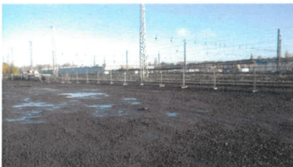
Bild 11: Schotterfläche im Nordosten des Grundstücks (17.11.2017)
