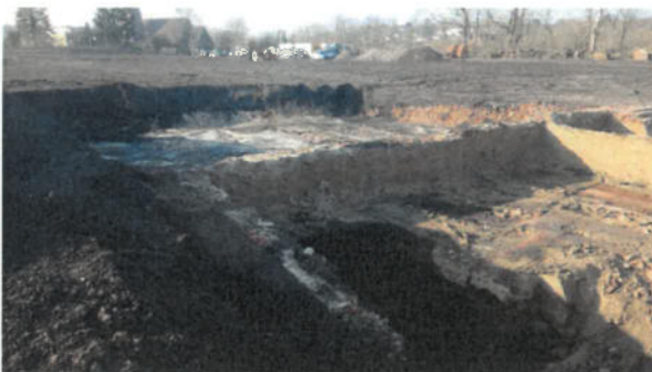
Bild 37: Freilegung großräumiger Fundamente und Mauerwerke der ehemaligen Steinhauser Hütte (Stahlwerk); (08.02.2018)
