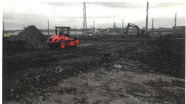
Bild 22: Einbau von RC-Schotter als Planum für den Straßenbau (11.01.2018)
