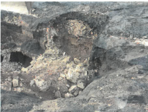
Bild 27: Im Untergrund angetroffenes Ziegel- und Natursteinmauerwerk im Bereich 1. TB (22.01.2018)
