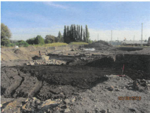
Bild 87: Weitere Verfüllarbeiten im Westteil des Areal (02.08.2018)
