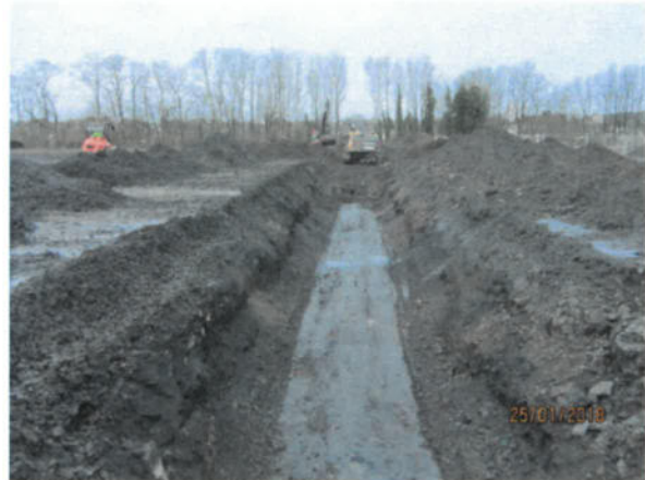
Bild 32: Verfüllungsarbeiten im Bereich des angelegten Suchschurfes südlich 1. TB (25.01.2018)
