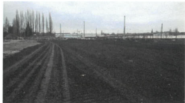
Bild 20: Für die Verdichtung vorbereiteter Nordteil der Fläche (10.01.2018)
