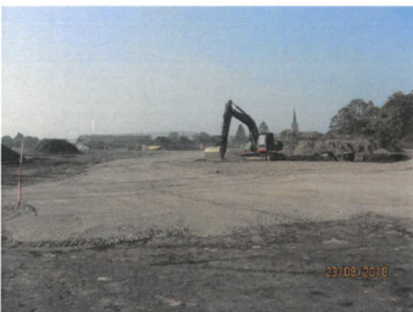
Bild 89: Fertiggestelltes Straßenplanum im Nordteil der Fläche; Bereich zukünftiger Wendehammer (23.08.2018)
