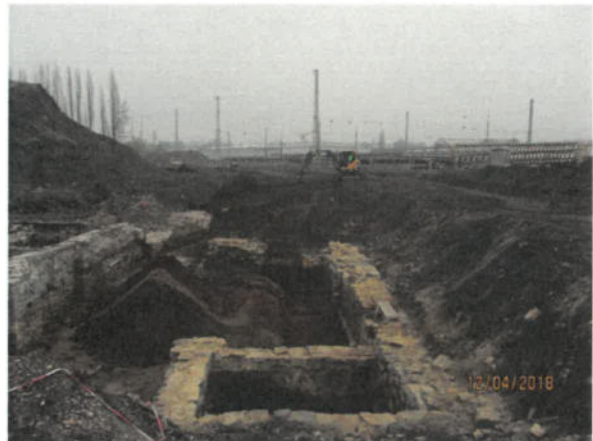
Bild 64: Natursteinmauerwerk der ehemaligen Bessemer Hütte im Südosten (12.04.2018)
