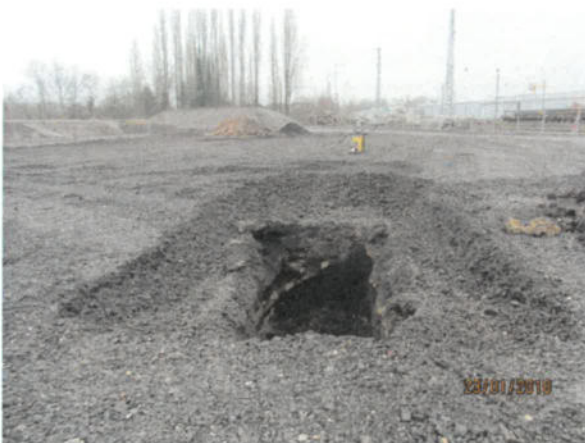
Bild 29: Erkundungsschurf zur Lokalisierung weiterer möglicher Bauwerksteile im Untergrund (23.01.2018)
