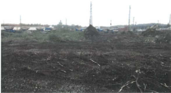
Bild 1: Blick von NE nach SW; Entfernen des Bewuchses (07.11.2017)
