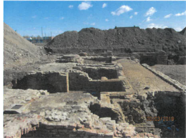
Bild 50: Blick nach Osten auf freigelegte Natursteinmauerwerke (20.03.2018)
