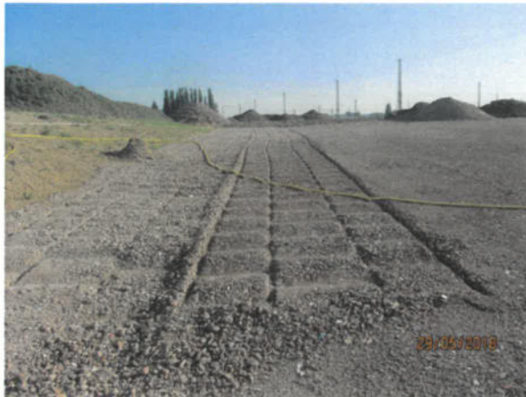
Bild 79: Bereits verdichtete Bereiche; Setzungen in Folge der Verdichtung rd. 10 cm (29.05.2018)
