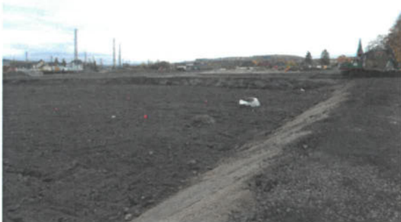
Bild 105: Mit Vlies und Boden abgedeckter "Schutzbereich A" (08.11.2018)
