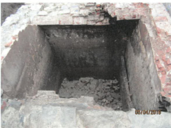
Bild 59: Freigelegtes Zisternenbauwerk der Steinhauser Hütte im NW (05.04.2018)
