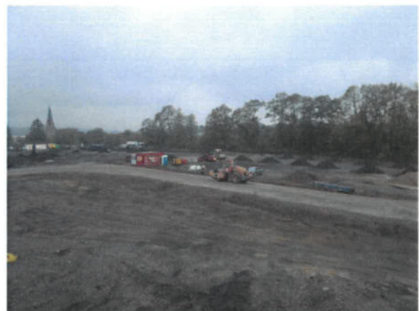
Bild 102: Nachverdichten des Planums für den Straßenbau im Nordteil (25.10.2018)
