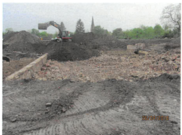
Bild 72: Fortschreitende Verfüllarbeiten in den bereits dokumentierten Bereichen (26.04.2018)
