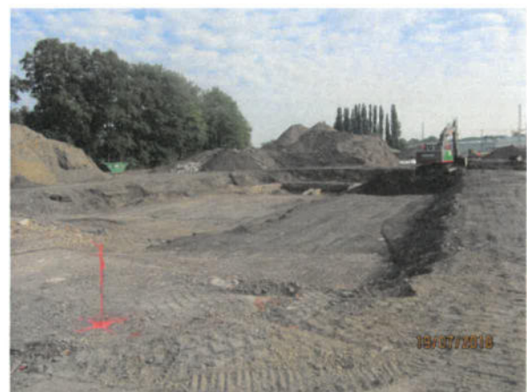
Bild 84: Lagenweise Verfüllung weiterer Teilbereiche im Süden des Gesamtgeländes (Bessemer Hütte) (19.07.2018)
