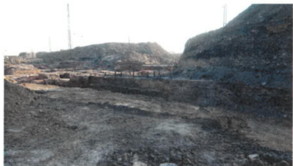
Bild 46: Fundamente und Stahlanker im Bereich der ehem. Walzenlager der Steinhauser Hütte (28.02.2018)
