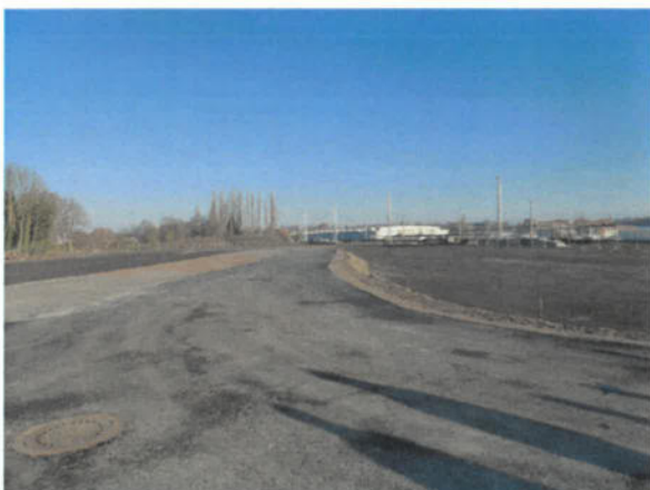
Bild 107: Blick auf die Baustraße nach Norden (23.11.2018)
