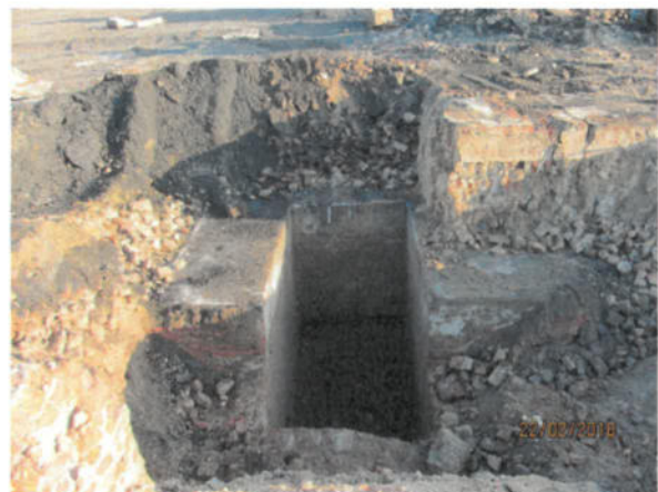
Bild 40: Auffinden einer weiteren "Etage" unterhalb von bereits freigelegten Bauwerksteilen (22.02.2018)
