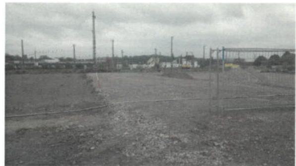
Bild 68: Fertiggestelltes Planum für den Straßenbau; Blick nach Osten (24.04.2018)
