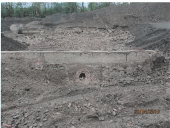
Bild 71: Freigelegter Zugang zu gemauertem Kanal im Bereich der Bessemer Hütte (26.04.2018)
