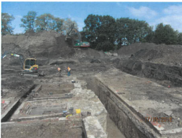
Bild 75: Freilegung weiterer Kanäle und sonstiger unterirdischer Infrastruktur der Steinhauser Hütte (17.05.2018)
