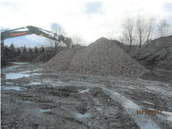
Bild 15: RC-Material zum Abdecken der NRW.URBAN-Fläche (14.12.2017)
