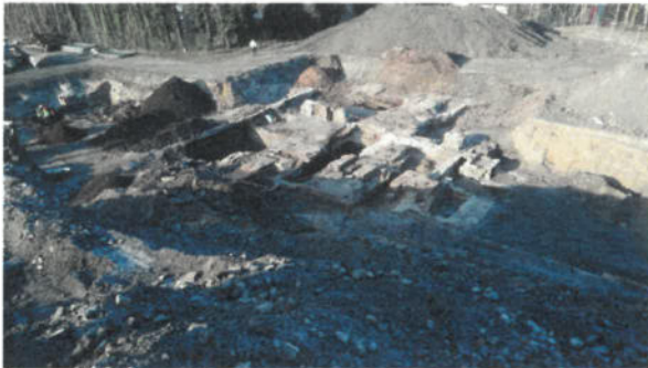
Bild 43: Freigelegte Bereiche der Steinhauser Hütte im Nordwesten der Fläche (28.02.2018)
