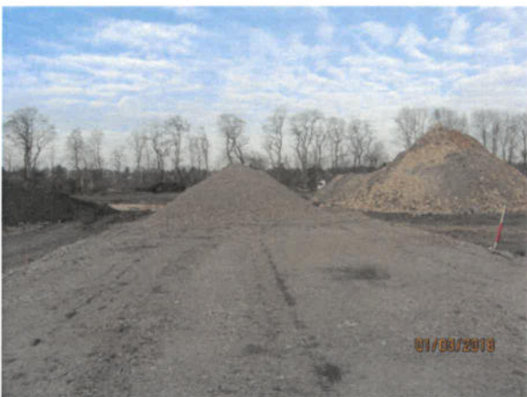
Bild 47: Für das weitere Straßenplanum bereitgestelltes RC-Material (01.03.2018)
