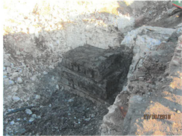
Bild 98: Freigelegter Schwingungsdämpfer aus Holz; massive, mehrlagige Eichenbohlen (27.09.2018)
