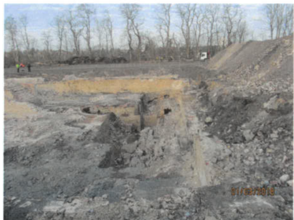
Bild 48: Abbruch der oberflächennahen Mauerwerke nach Abschluss der archäologischen Dokumentation (01.03.2018)
