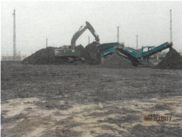
Bild 13: Absieben des Oberbodens zur Wiederverwertung in Grünbereichen (05.12.2017)
