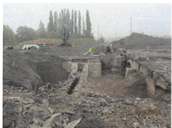
Bild 96: Rückbau der kontaminierten Walzenlager mit Separation von belastetem und unbelastetem Bauschutt (13.09.2018)
