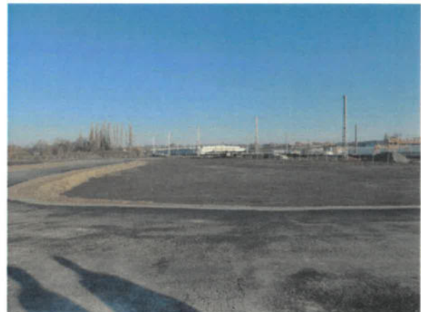
Bild 106: Blick vom "Mittelast" der fertigen Baustraße nach Norden (23.11.2018)
