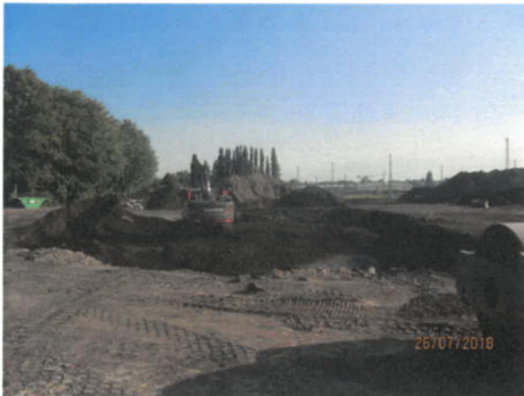
Bild 85: Weitere Verfüllarbeiten im SW des Geländes (26.07.2018)
