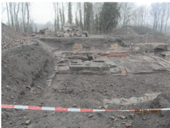
Bild 53: Weitere Fundamente und Mauerwerksreste im NW der Steinhauser Hütte (22.03.2018)
