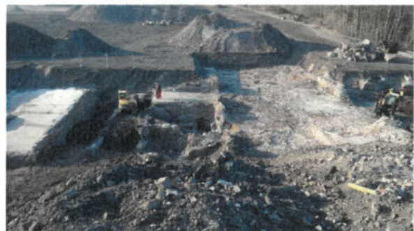
Bild 42: Freilegung und sukzessive Verfüllung der zu dokumentierenden Bereiche (28.02.2018)
