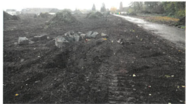
Bild 4: Rückbau von ehemaligen Fundamenten aus dem westlichen Randbereich der Straße (10.11.2017)
