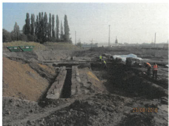
Bild 90: Walzenlager im Westen nach Aushub der belasteten Sedimente (23.08.2018)
