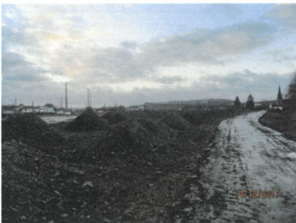
Bild 17: Randsteine aus dem Straßenbereich wurden entfernt (14.12.2017)
