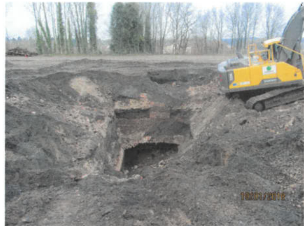
Bild 26: Baggerschurf zur Eingrenzung der unterirdischen Bauwerke im Bereich des 1. Tagesbruchs -1. TB- (19.01.2018)
