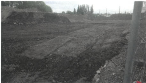
Bild 67: Blick von S nach N; lagenweise Verfüllung der Aushubbereiche (24.04.2018)
