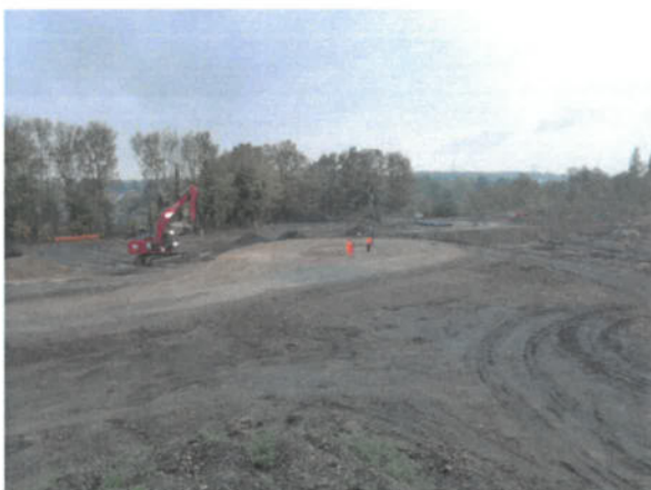
Bild 101: Fertiggestelltes Planum im Bereich des zukünftigen Wendehammers (25.10.2018)
