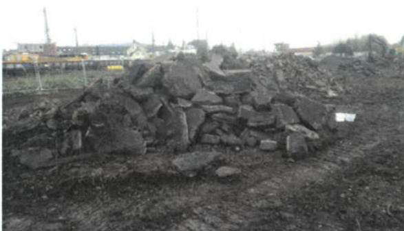
Bild 5: Schlackenhaltiger Beton aus den verbliebenen Bauwerken im Osten der Fläche (10.11.2017)
