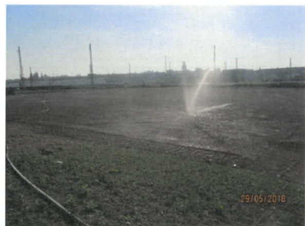
Bild 78: Befeuchtung der Fläche zur Staubniederschlagung (29.05.2018)
