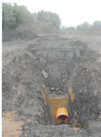
Bild 95: Rückverfüllter Kanalgraben (13.09.2018)
