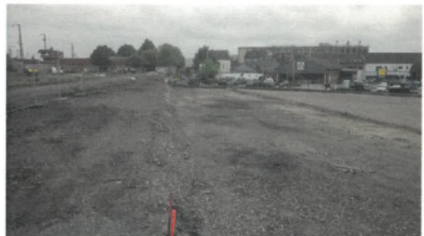
Bild 70: Fertiggestelltes Planum für den Straßenbau; Blick nach Süden (24.04.2018)
