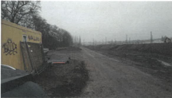
Bild 19: Ehemaliger Straßenverlauf im Westen nach Rückbau der Asphaltdecke (21.11.2017)
