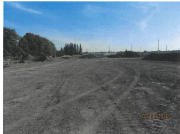
Bild 86: Blick von S nach N; bereits wieder verfüllt und verdichtete Teilbereiche (02.08.2018)
