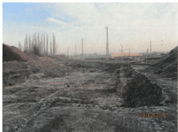
Bild 36: Erste Aushubarbeiten in Begleitung archäologischer Fachfirmen; Blick nach Norden (08.02.2018)
