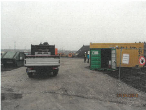
Bild 63: Baustelleneinrichtung wird nach SE umgesetzt (12.04.2018)
