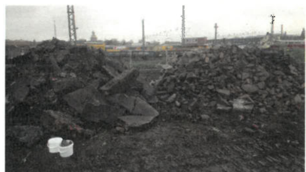
Bild 6: Ziegel und Natursteine aus den verbliebenen Bauwerken im Osten der Fläche (10.11.2017)
