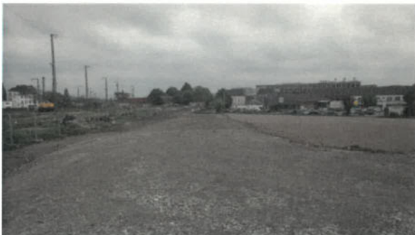
Bild 69: Fertiggestelltes Planum für den Straßenbau; Blick nach Süden (24.04.2018)
