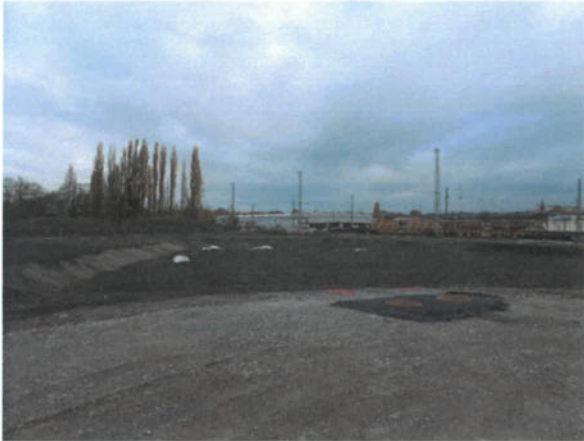
Bild 103: Mit Vlies und Boden abgedeckter "Schutzbereich A" des freizuhaltenden "Archäologiefensters" (05.11.2018)
