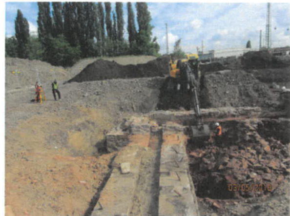
Bild 74: Ehemaliges Walzenlager mit Stahlanker im Westen (03.05.2018)
