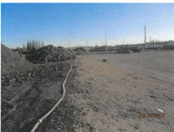
Bild 65: Befuchtung der Bodenmieten und der Aushubbereiche zur Staubbildung (19.04.2018)
