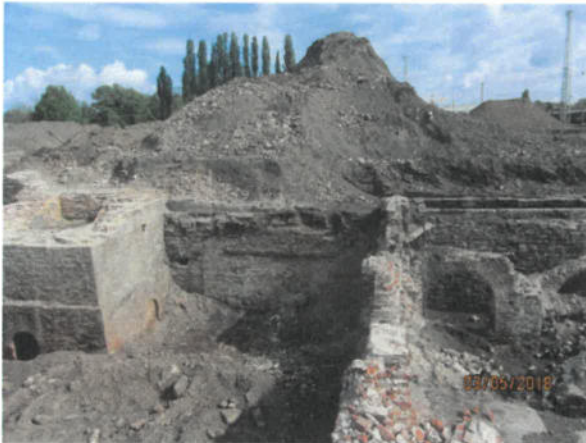
Bild 73: Freilegung des ehemaligen Schornsteinfundamentes und weiterer Bauwerke der Steinhauser Hütte (03.05.2018)
