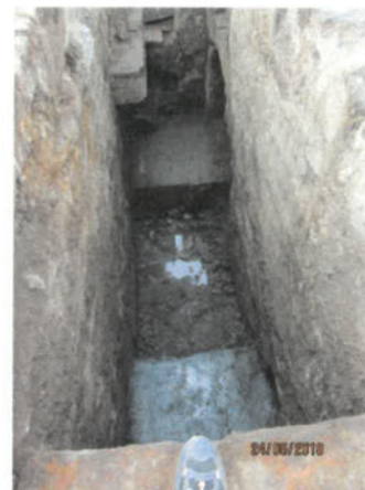
Bild 76: Kontaminationen im Bereich des westlichen Walzenlagers der Steinhauser Hütte (24.05.2018)
