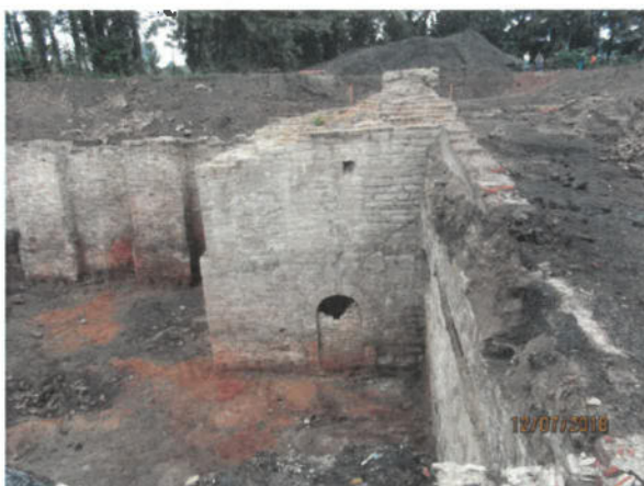
Bild 83: Blick nach Westen auf das Schornsteinfundament der Steinhauser Hütte (12.07.2018)
