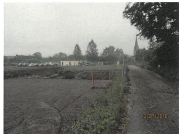
Bild 82: Zur späteren Verdämmung der verbleibenden Kanäle und Hohlräume eingesetzte KG-Rohre im Westen des Geländes (12.07.2018)
