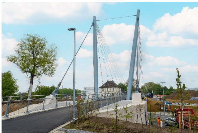
Fuß- und Radwegebrücke am Rheinischen Esel
